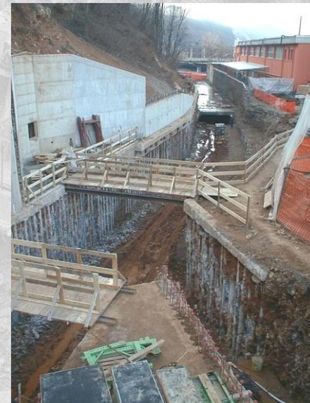
**Interventi:** Nuovo gruppo Kaplan, nuova centrale, automazione completa e affidabile, nuovo canale di scarico, sovralzato della traversa, risanamento e sovralzato delle sponde del canale di carico, nuova scala pesci, rilascio affidabile del DMV.
